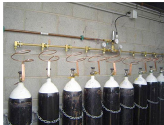
شکل ۱۷ نمونه‌ای از سیلندرهای متصل شده به منیفولد مرکزی
